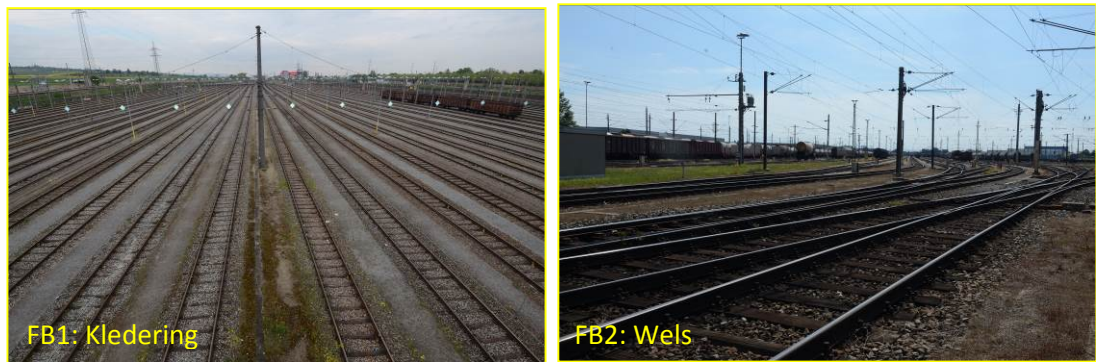
Figure 40: Switchyards (FB1 und FB2).
